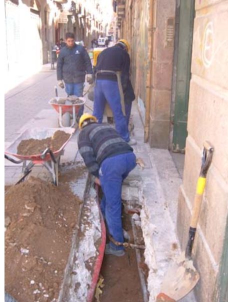
Foto 10. Realització de la rasa 2.
